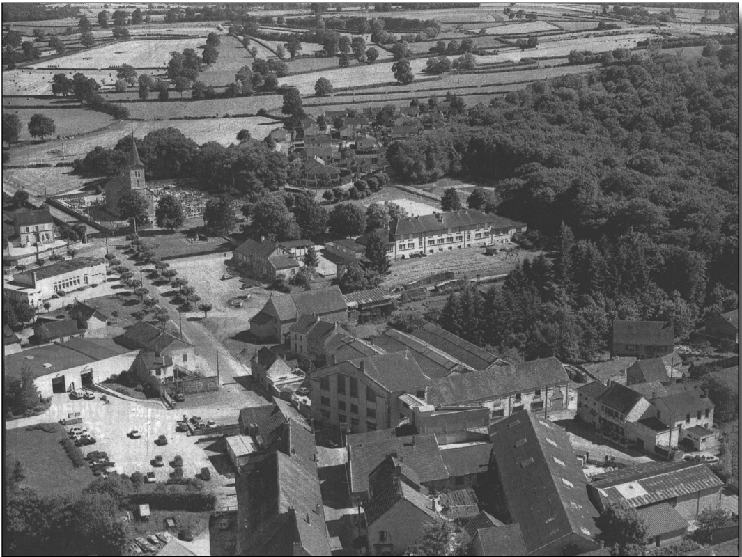
1. L'industrie au cœur du village : vue aérienne de Foulange en 1998. Les bâtiments industriels, rénovés ou abandonnés, sont au centre du village (en bas, à gauche, l'atelier de la SMF). © BP-LD Imatec.
